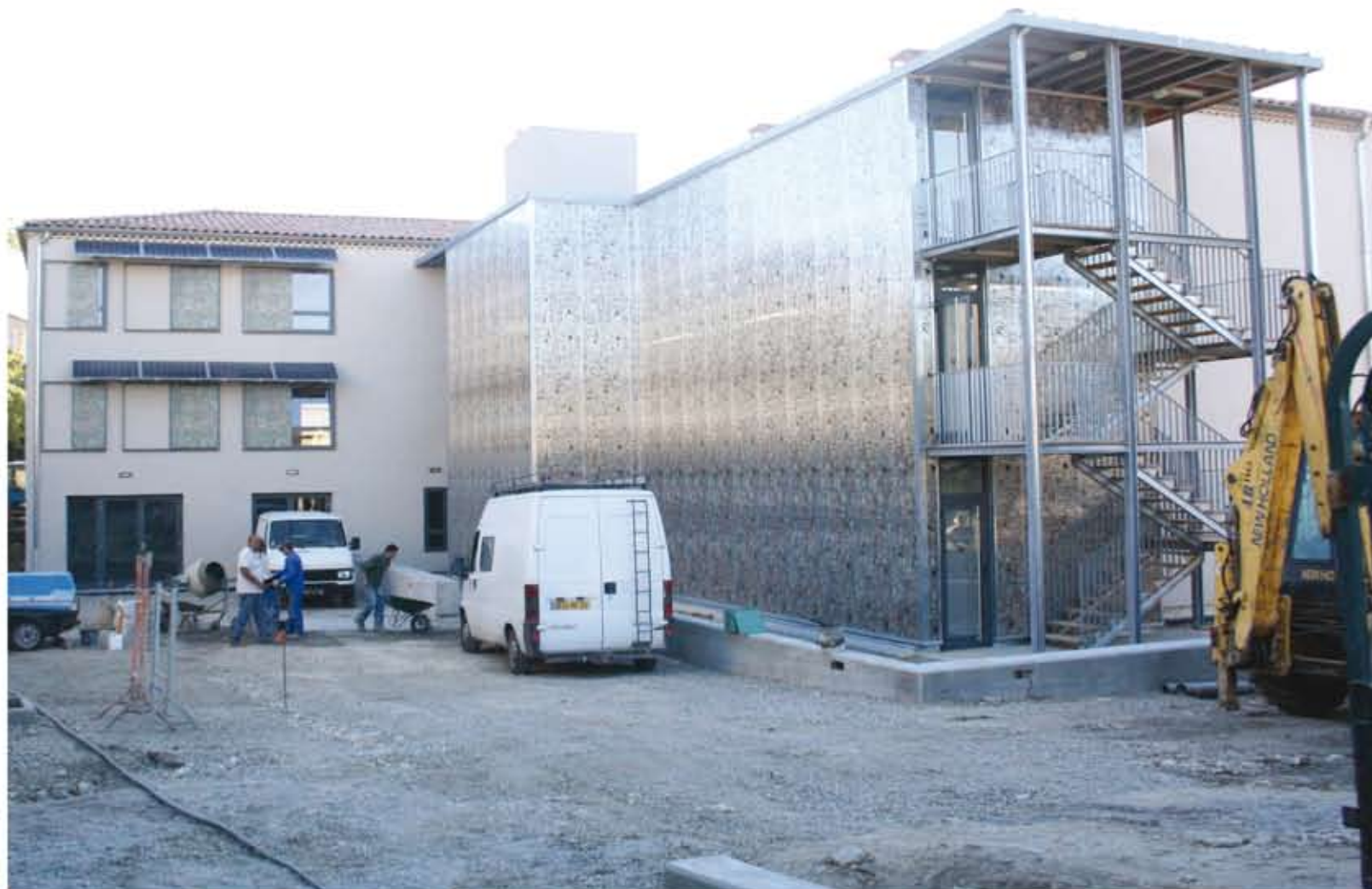
La maison des métiers du livre est presque terminée, il ne reste plus qu'à réaliser le revêtement du sol devant le bâtiment.
